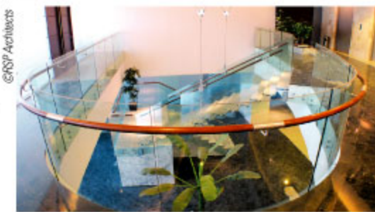
新加坡樟宜国际机场的夹层玻璃栏杆，它含有Butacite® PVB中间层。
