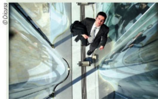
Rem Koolhaas设计于2005年建成的Casa di Musica音乐厅位于葡萄牙波尔图市。Ferran Figuerola在下面往上看：弧形夹层玻璃要求卓越的音效。
